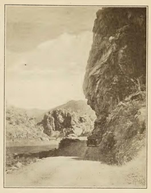
ROAD ALONG THE UPPER ARKANSAS RIVER, NEAR SALIDA, COLORADO, BLASTED FROM SOLID ROCK AND COMPOSED CHIEFLY OF DISINTEGRATED RED GRANITE.
